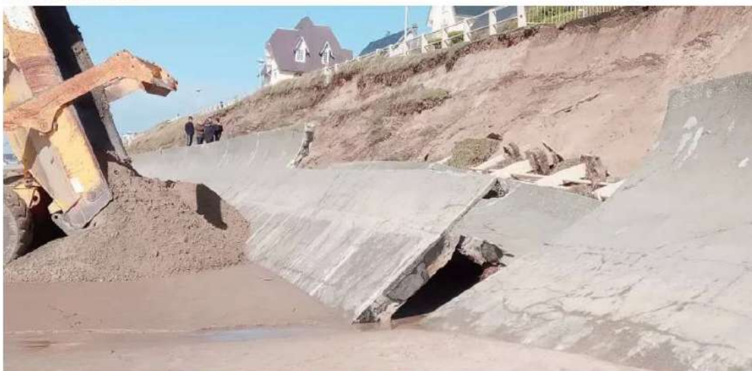
Dès l'après-midi les engins de chantier ont commencé à combler et empierrer à l'endroit où la digue a cédé à hauteur de l'avenue de Scissy. - Michel Saint-Martin
