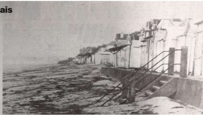
À Jullouville le niveau de la plage a remonté considérablement, faisant disparaître une partie des escaliers d'accès à la plage.
