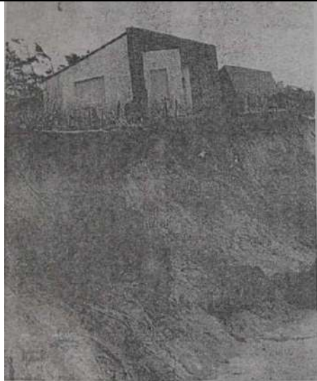
Au Pont-Bleu, deux maisons sont menacées par le recul de la dune.
