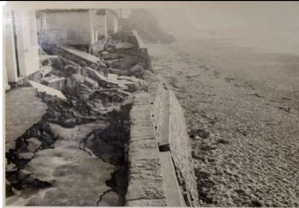
Digue détruite par la tempête du 1er Novembre 1967.
