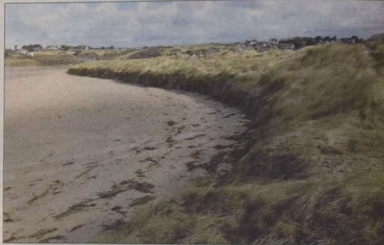
Au mois de février, le cordon dunaire, protégeant les villas de Kairon-plage, a été attaqué.
