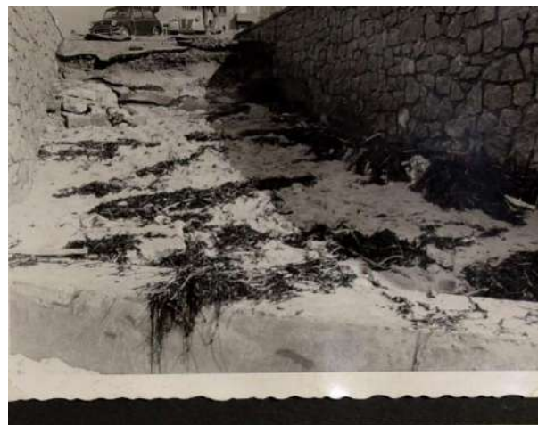
Cale des pêcheurs détruite le 1er novembre 1967.
